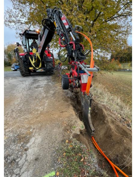
Verlegung der Leerverrohrung mittels Pflug
